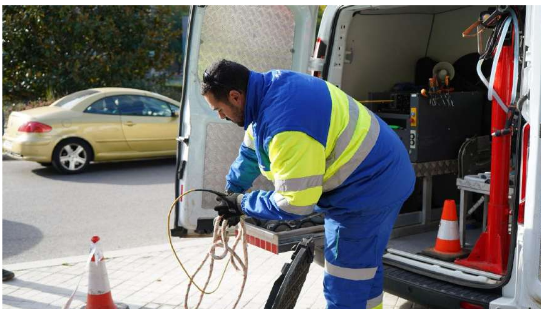
Un operario mirando la red de alcantarillado. Ajuntament de Reus
