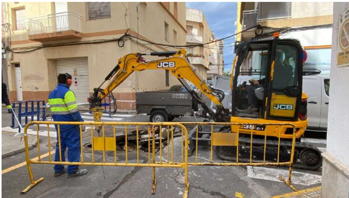
Les obres en marxa a l'Ametlla de Mar. Ajuntament de l'Ametlla de Mar
