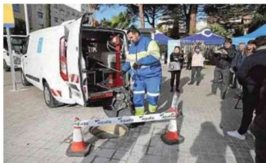
Els treballadors d'Aqualia van fer una demostració amb les càmeres que utilitzen per inspeccionar i mantenir la xarxa. FOTO: ALBA MARINÉ
