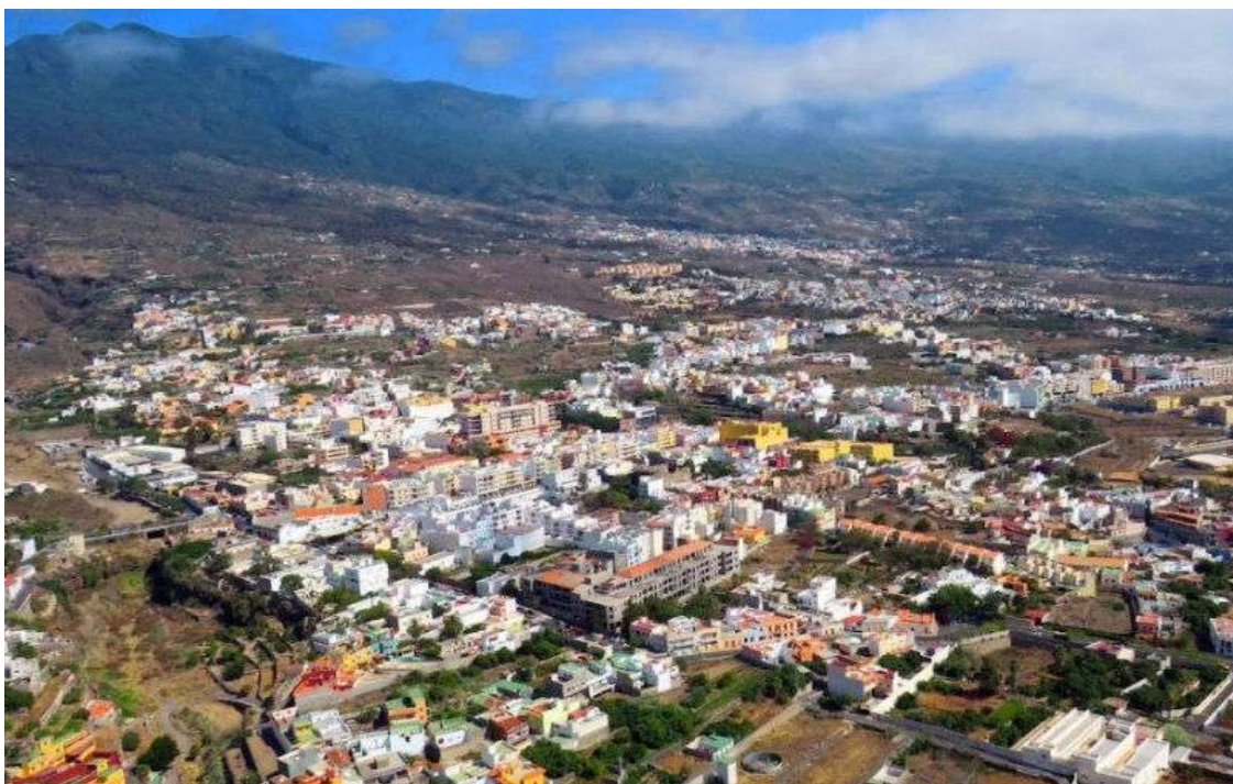
Más de 15 toneladas de basura y toallitas bloquearon las alcantarillas de Güímar / Archivo RTVC
