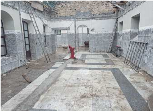
Obras icónicas. Las nuevas infraestructuras acaparan buena parte de las cuentas municipales, como la actuación en la casa de baños del balneario, en pleno centro urbano.
